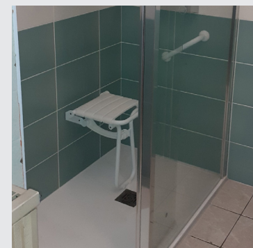
Adaptation d'une salle de bains en salle de douche avec siège de et barre d'appui
